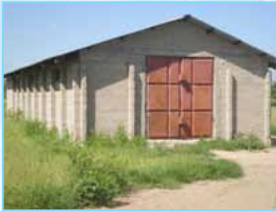
Benki Mazao katika hatua za mwisho za ujenzi
